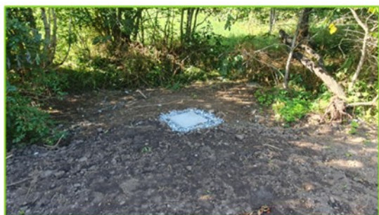
Création d'un puits perdu
