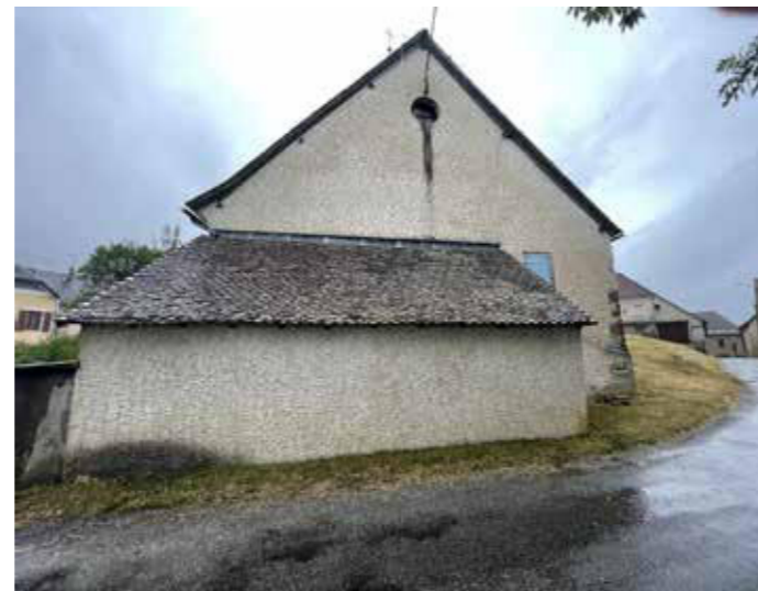
Route communale bordant la maison à l'Est
