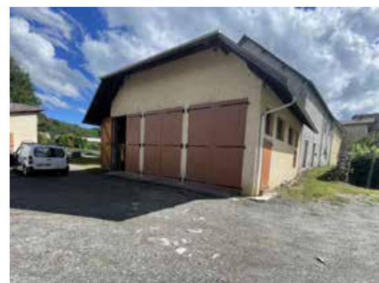
Façades Nord et Ouest
