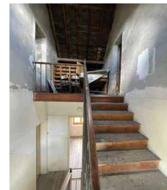
Dernière volée escalier commun vers combles
