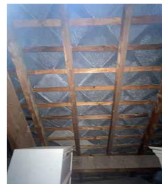
Charpente et couverture combles
