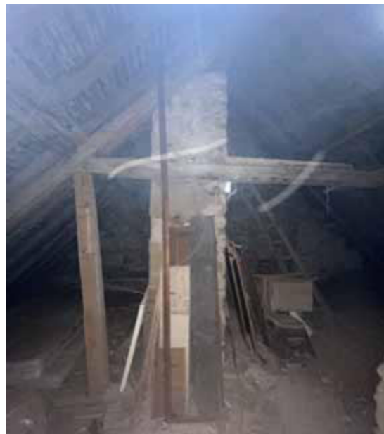
Poteau porteur charpente
