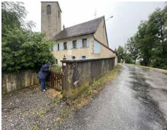
Portail d'accès depuis la voie communale
