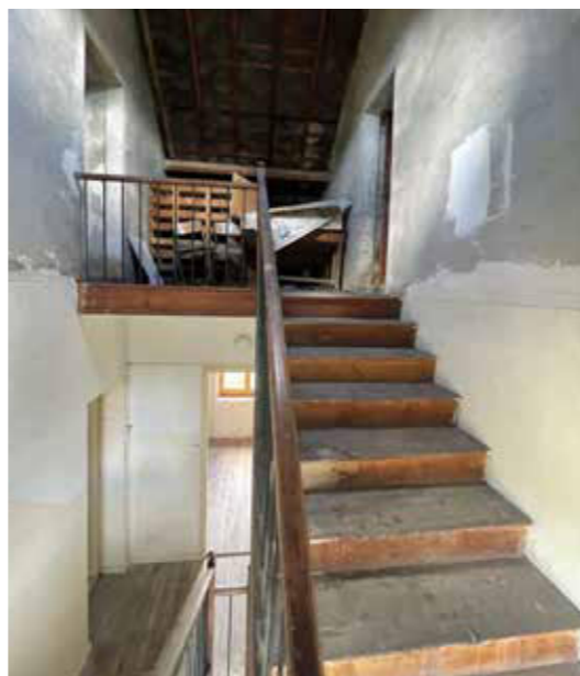
Escalier bois - accès aux combles
