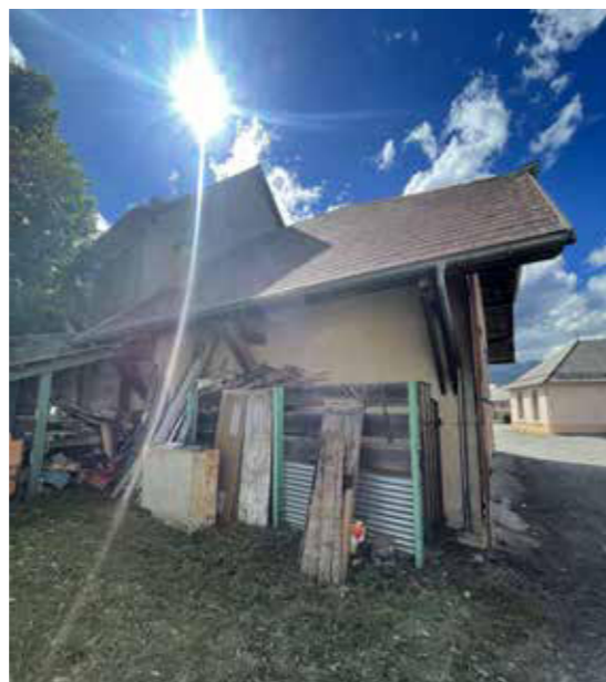
Façade Est / appentis
