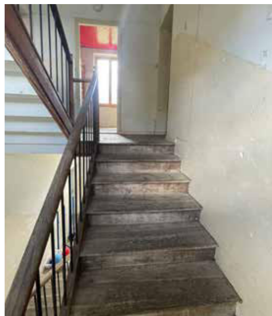
Escalier bois - 1ère volée
