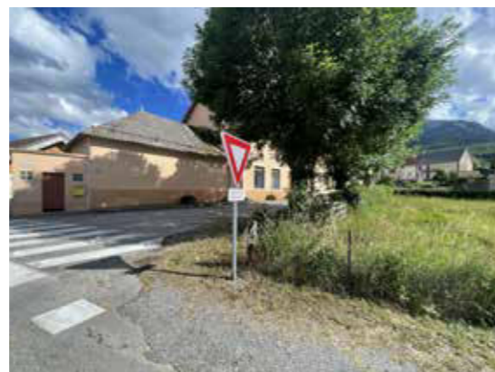
Façade Ouest depuis D17
