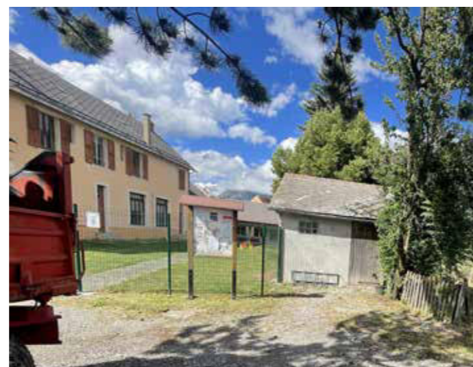
Accès façade Est depuis la cour de l'école
