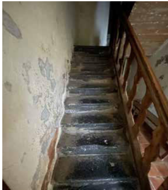
Escalier pierre de taille
