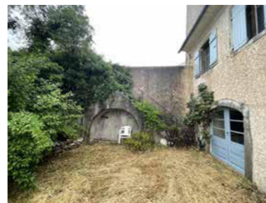
Façade Sud et mur Ouest
